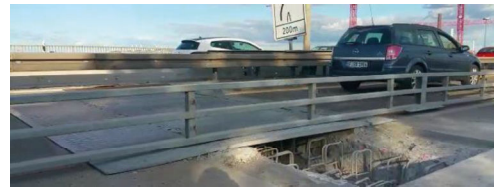
Flyover mit Stahlanrampung (
