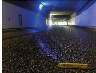
Oberflächenbearbeitung mit Grinding-Abtrag, ca. 5 mm
