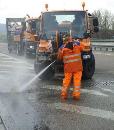
Unterhaltsarbeiten an einer Modulardehnfuge mit Lärmschutz
