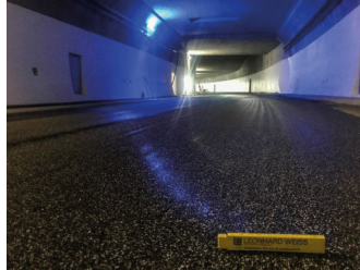
Oberflächenbearbeitung mit Grinding-Abtrag, ca. 5 mm
