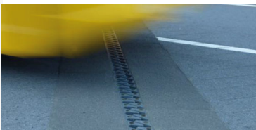
Einzelige Fahrbahnübergang mit oder ohne Lärmschutz, verankert durch Verklebung oder mittels Schlaufenanker
