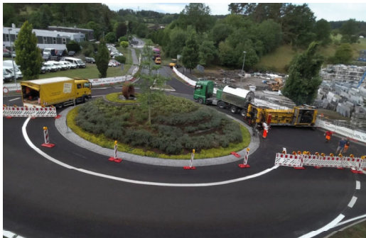
Kreisverkehrsplatz Rutesheim 1.200 m 2 maschineller Einbau Gussasphalt MA 11 S Dicke 35 mm 15/25 VL Verfahren A mit bit.Moräne 2/5
