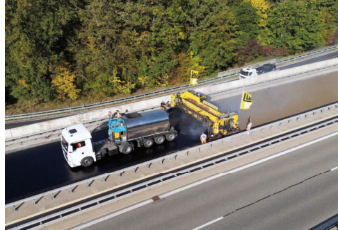
Heslacher Tunnel Stuttgart-Schattenring Oberflächenbearbeitung nach Verfahren B mit Granulit 2/4, farblos umhüllt
