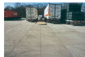
Tiré de T61, collection technique Cimbéton
