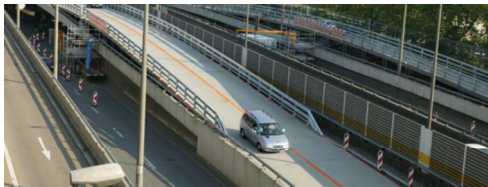
Temporäre Flyover-Brücke ermöglicht Arbeiten unterhalb der Überbrückungen (Asfinag, ASTRA)
