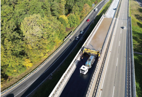
Heslacher Tunnel Stuttgart-Schattenring 8.500 m 2 Deckschicht MA 8 S mit PmB 10/25 VL, 35 % Granulit
