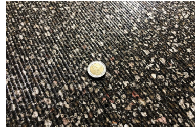
Verwendung von 35 % künstlichem Aufhellungsgestein Granusil, um Anforderung an Leuchtdichte zu erfüllen. Ebenheit <2 mm auf 4m
