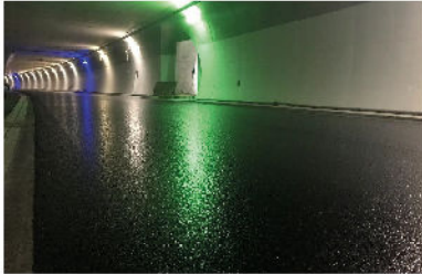
Rosensteintunnel, Stuttgart, Grinding 25.000 m 2 Deckschicht, MA 11S 25/55- 55 aufgehellt, Einbaudicke 35 mm
