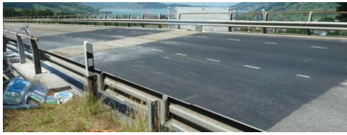
Flyover liegt auf der Fahrbahn und erhält eine Asphaltanrampung (mageba)
